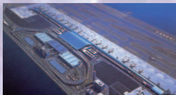
JFE30-2の屋根材への適用例 (関西国際空港ターミナルビル)
