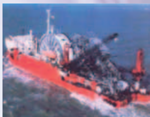
12Cr 系ラインパイプの敷設状況
