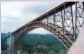
無塗装耐候性鋼適用橋
