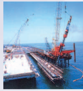
重防食鋼管杭適用栈橋
