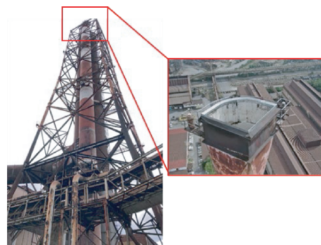
写真2 煙突点検へのドローン活用 Photo 2 Drone utilization for chimney inspection
