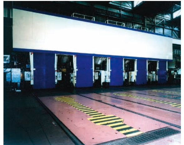
完全連続式冷間圧延機
