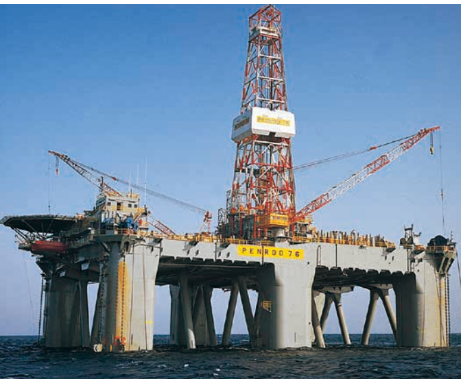
半潜没式石油掘削リグ/Semi-submersible drilling rigs
