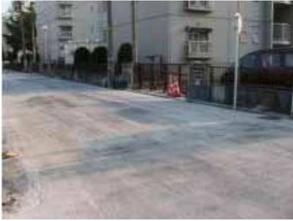
ヒートアイランド現象抑止舗装施工例(車道)
