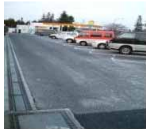
ヒートアイランド現象抑止舗装施工例(駐車場)
