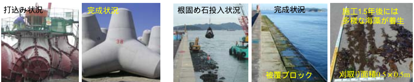
消波ブロック製作状況
