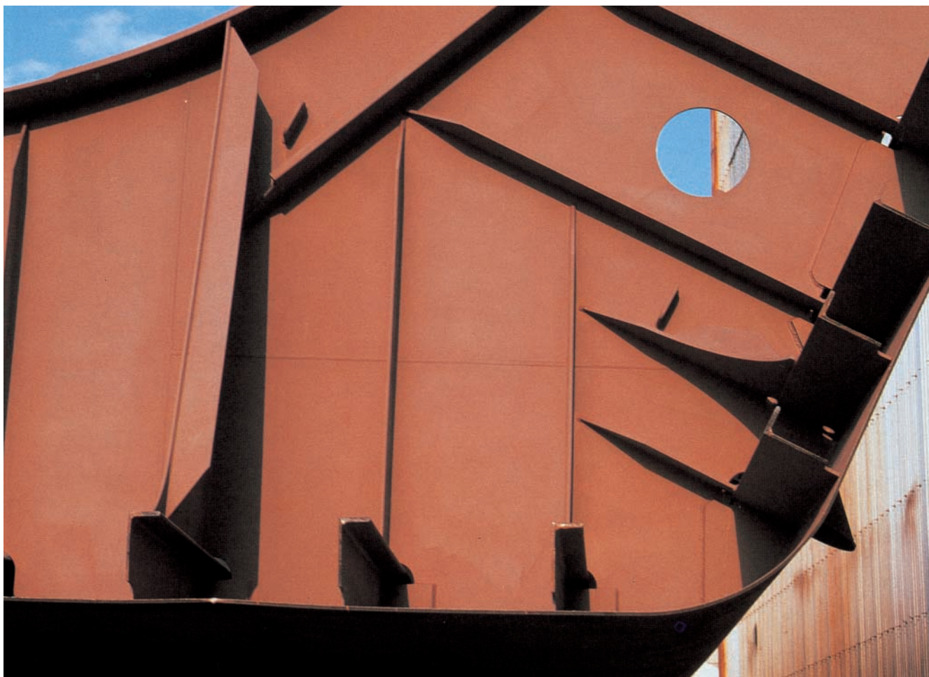
建造中の船体ブロック
