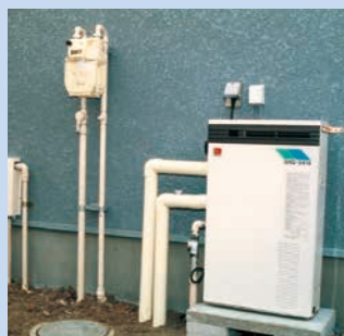
▲ガス用ポリエチレン被覆鋼管
