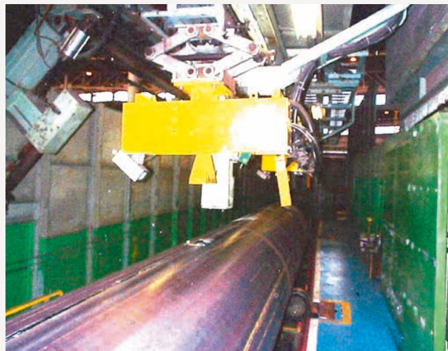
▲中央部X線透過検査設備
