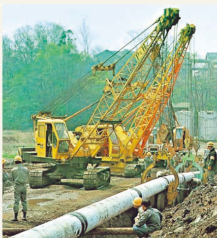
ラインパイプ施工中
