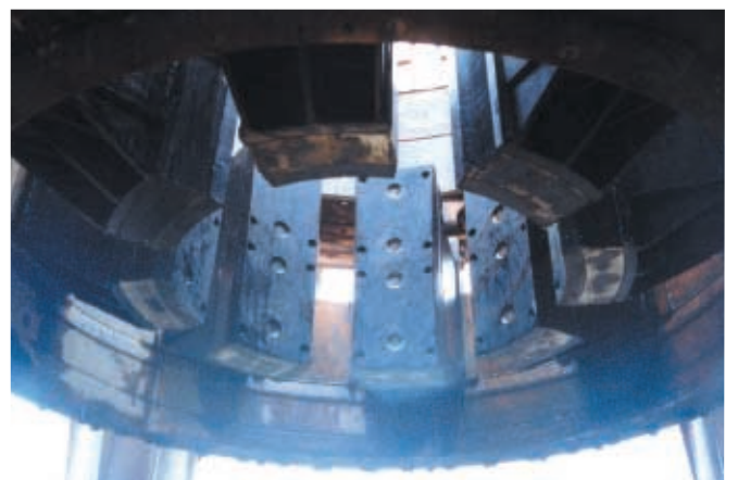
杭胴体チャック部（全周回転機）
