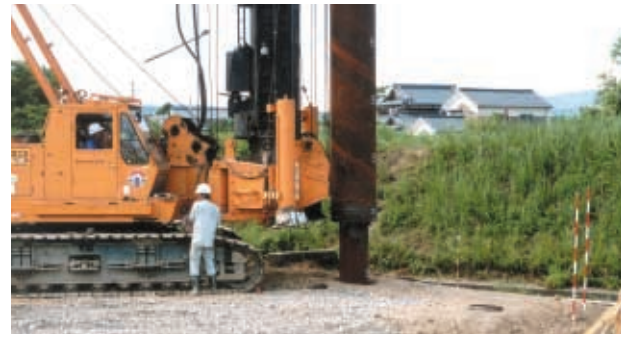
拡頭杭の施工
