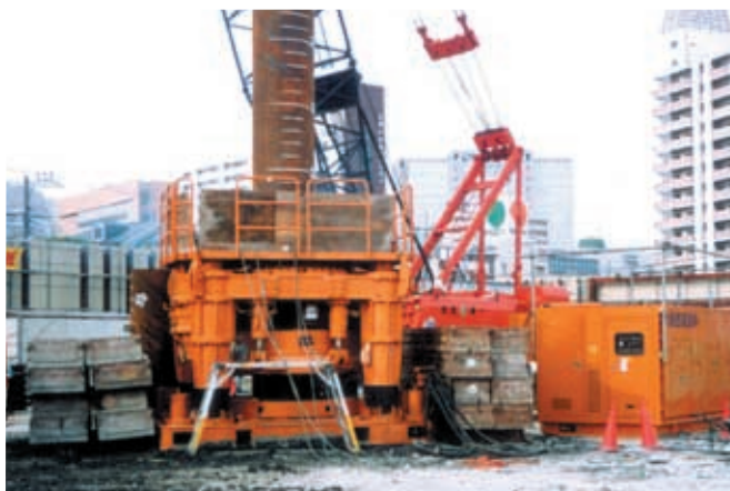
施工状況（全周回転機）
