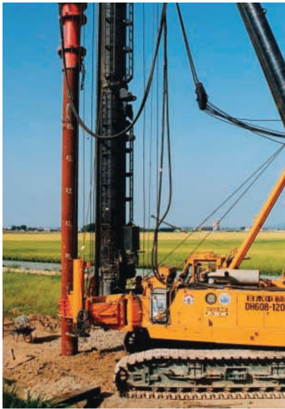
施工状況（三点式杭打ち機）
