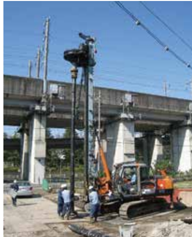
小径杭の施工状況
