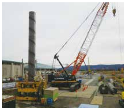
全周回転機による施工
