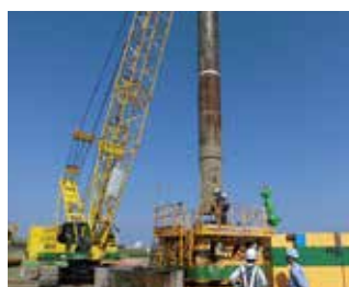
ヤットコ挿入状況
