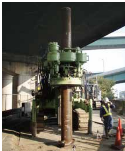
低空頭・狭隘地施工
