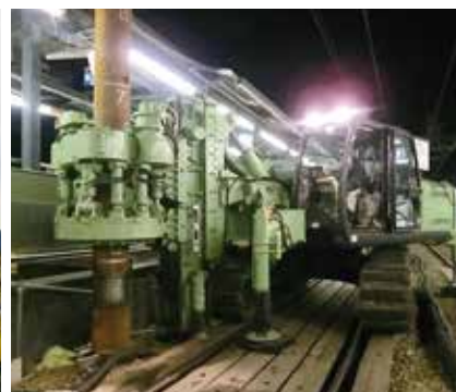
軌道内施工、機械式継手
