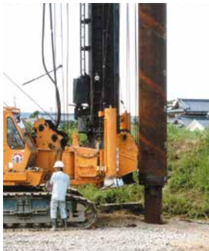
拡頭杭の施工
