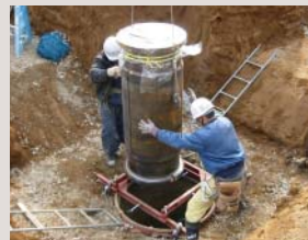
2.接合鋼管建込み
