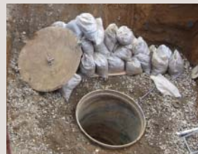
1.杭頭部根切り
