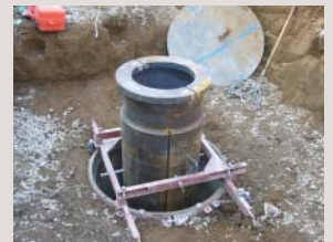
3.接合鋼管設置
