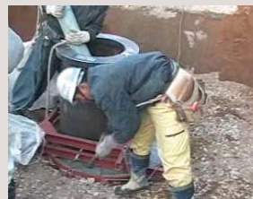
4.杭内部コンクリート打設
