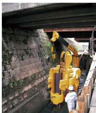
橋桁下への適用事例
