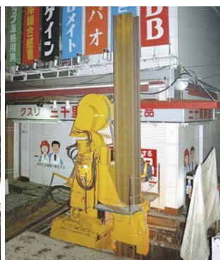
近接施工状況
