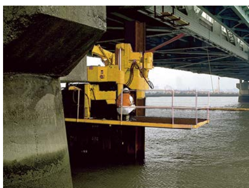
橋脚に近接した仮締切り施工状況
