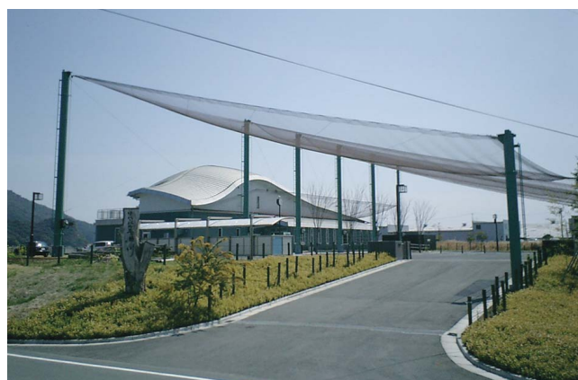
管理用道路上空の防護
