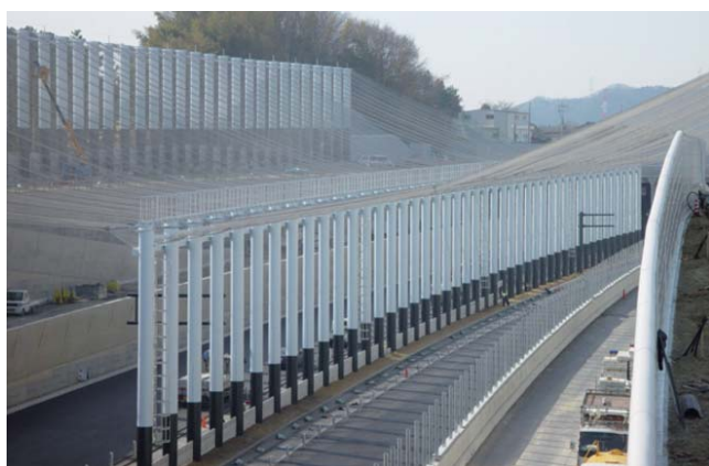
高速道路上空の防護
