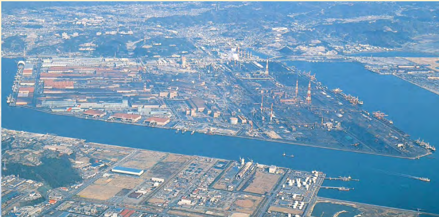
西日本製鉄所 福山地区
