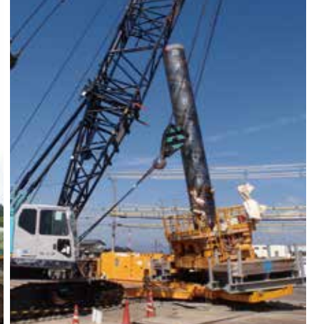
Pile body rotation type (Batter pile)
