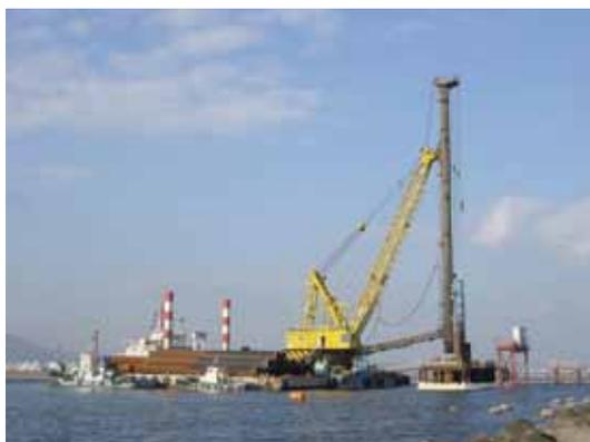
桥梁（钢管板桩基础）
