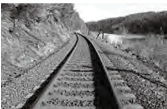
写真1 『SP3』の敷設場所
