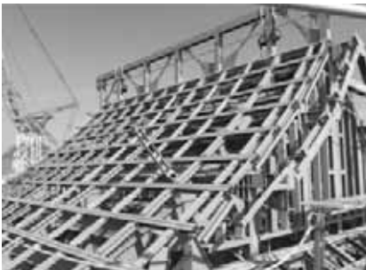
図2 熊本城大天守6階鉄骨造の外観
