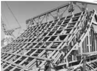
図2 熊本城大天守6階鉄骨造の外観
