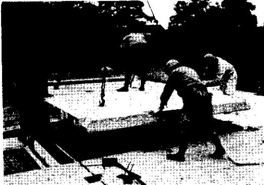
写真13 床PC版の敷込作業
