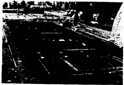
写真 2 PC版型枠と配筋 (E棟)
