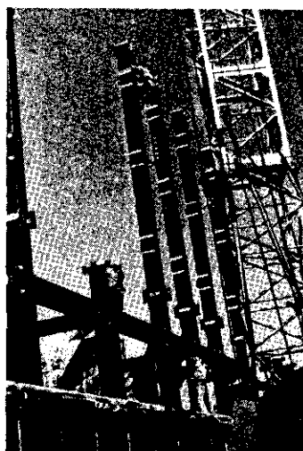
写真 4 鉄骨の建方 (E棟)
