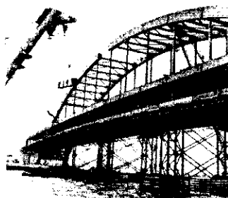
写真 3 1,000t吊フローティングクレーンによるアーチ部架設
